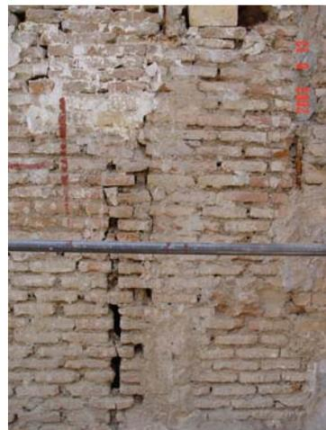
Bild 5) Mauerwerk, das mit faserverstärkten Kunststoffen verstärkt werden könnte
