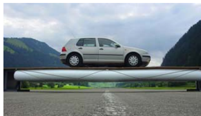
Tensairity-Demonstrationsbrücke mit 8 Meter Spannweite und 3.5 Tonnen maximaler Belastung
