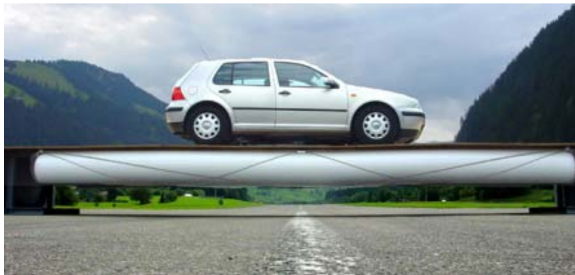
Tensairity® – Demonstrationsbrücke: Spannweite: 8 m; maximale Last: 3.5 t
