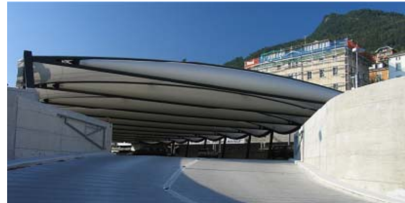
Tensairity® – Überdachung: Parkhaus Montreux; Spannweite: 28 m
