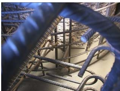
Le béton autocompactant permet de remplir les vides les plus compliqués.
