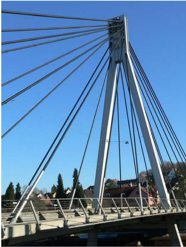
Die 1996 eröffnete Storchenbrücke in Winterthur, eine Strassenbrücke über die SBB-Gleisanlagen, hat Spannweiten von rund 61 und 63 Metern. Die Höhe des Mittelpylons beträgt 38 Meter. Als Weltneuheit wurden neben 22 konventionellen Paralleldrahtkabeln auch zwei CFK-Schrägseilkabel eingebaut.
