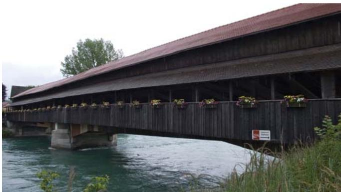
Die Holzbrücke in Sins im Kanton Aargau aus dem Jahr 1809 wurde in den 1990er-Jahren mit CFK-Lamellen von aussen nicht sichtbar verstärkt.
