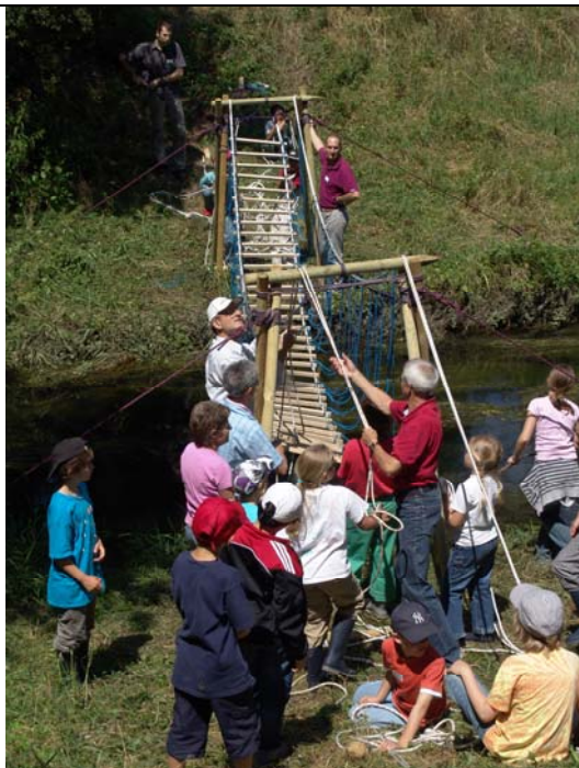
Damit die Brücke nicht schwingt, müssen die Seile richtig gespannt sein. (2008-07-18 sommercamp-bruecke5.jpg)
