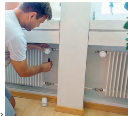
2 La conversion thermostats analogiques / thermostats intelligents viboo Cloud est facile à effectuer dans les installations existantes et permet des économies d'énergie de 20 à 40 pourcent.
