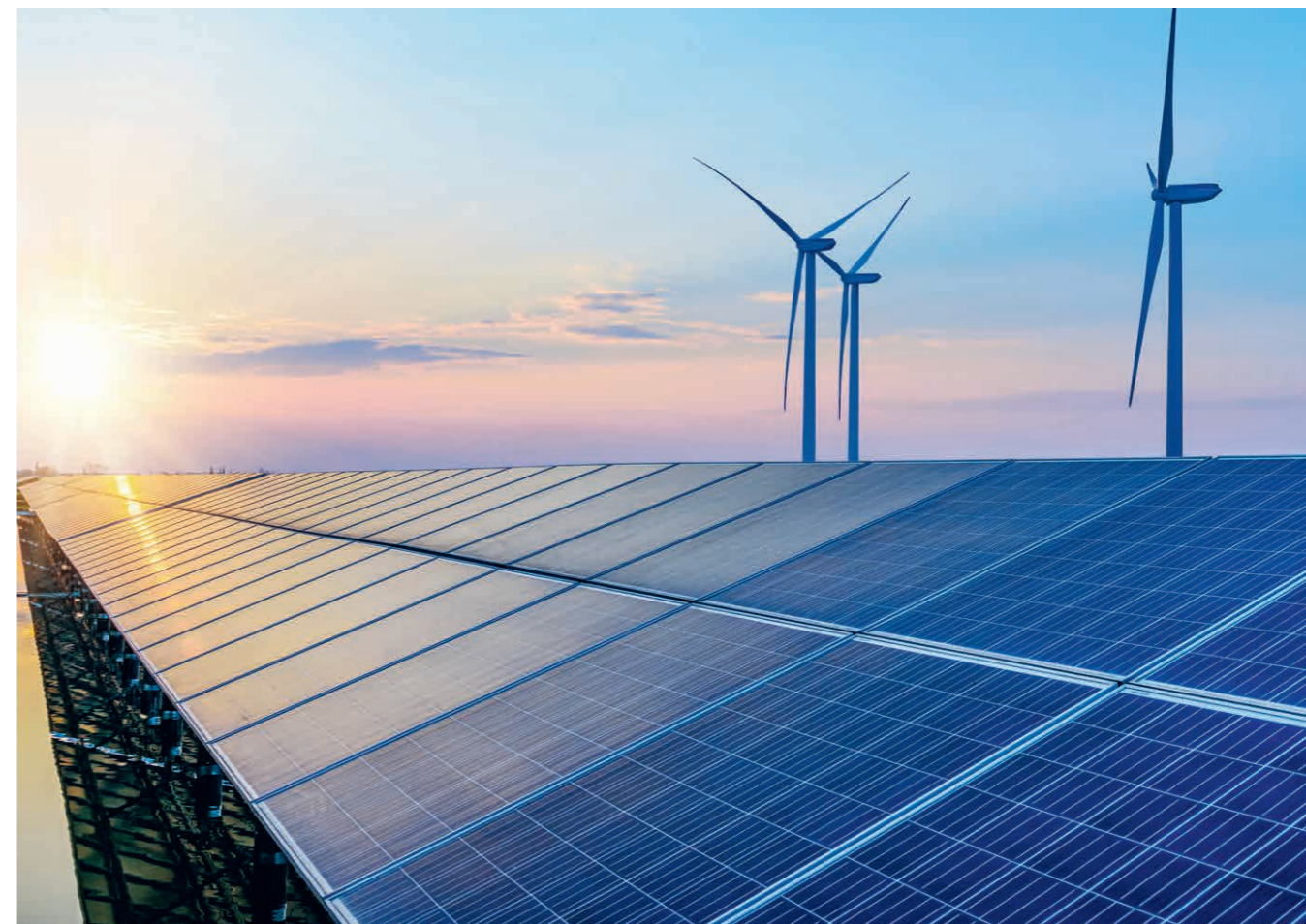
Um die Flexibilität des Energiesystems zu steigern, muss der Ausbau und die Integration erneuerbarer Energien sowie die Sektorkopplung beschleunigt werden. Das ehub-Team ist an diversen Projekten beteiligt, um dies voranzutreiben. Bild: Adobe Stock
