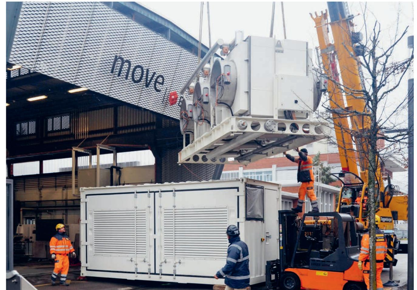
Speziallieferung für «move»: Ende November 2021 wurde eine Direct-Air-Capturing-Anlage von Climeworks in den Mobilitätsdemonstrator der Empa geliefert. Mit der Anlage wird CO<sub>2</sub> aus der Atmosphäre gewonnen, das in einem weiteren Schritt für die Herstellung von synthetischem Methan verwendet wird.
