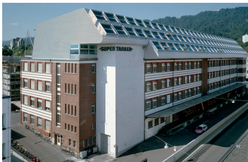
Abb. 10 Supertanker: Umbau und Aufstockung (2007) in Holzbau von einem bestehendem Lagergebäude in Zürich Binz (Foto: Stücheli Architekten AG)
