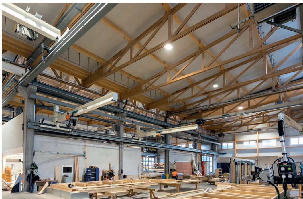
Abb. 4 Bau der Produktionshalle für den Bereich Holzbau von Implenia in Rümlang mit Fachwerken aus Buchenfurnierschichtholz (Foto: Implenia Schweiz AG / Holzbau)
