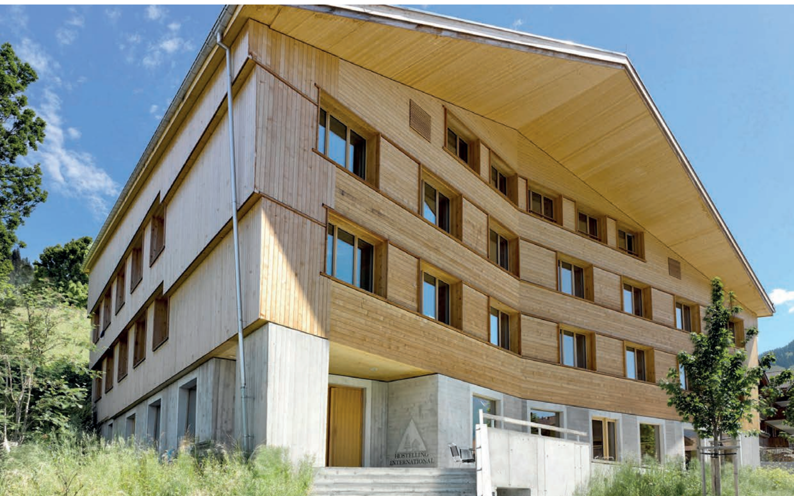
Abb. 2 Die 2014 eröffnete Jugendherberge Gstaad Saanenland vom Berner Büro Bürgi Schärer Architektur und Planung ist die moderne Interpretation des klassischen Saanenländer Chalets. Das Gebäude ist eine Hybridkonstruktion in Beton, Mauerwerk und Holz. Fassaden- und Dachkonstruktion bestehen aus vorfabrizierten und hochwärmedämmten Holzelementen. (Foto: BÜRGI SCHÄRER Architektur und Planung AG, Alexander Gempeler)
