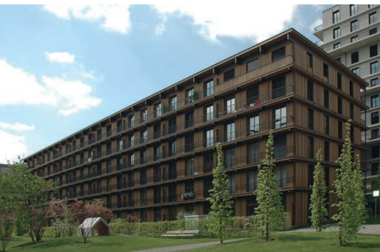
Abb. 9 Freilager-Überbauung in Zürich Albisrieden, eines der grössten 2016 eingeweihten Wohnbauprojekte auf dem Gebiet der Stadt Zürich (Foto: Lignum Michael Meuter, Zürich)
