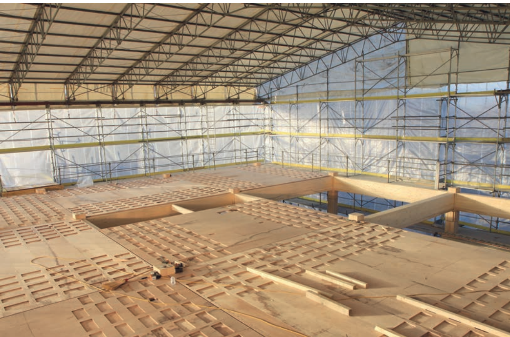
Abb. 5 Buchenurnierschichtholz-Platten als Schalung und Bewehrung für die Holz-Beton-Verbunddecke im ETH House of Natural Resources, Zürich Hönggerberg (Frangi, 2014) (Foto: ETH Zürich / IBK)
