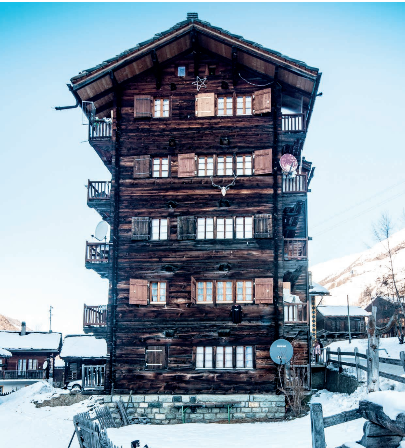
Abb. 8 Fünfgeschossiges Wohnhaus in La Tour (Wallis) aus dem Jahr 1958 (Foto: JHG Photography)
