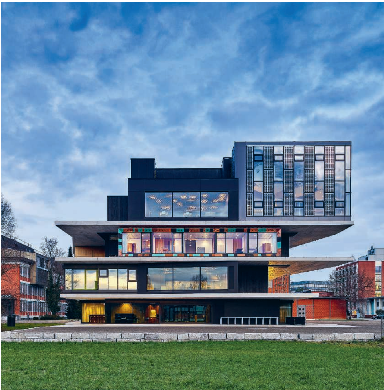
Vue Est de NEST avec sa nouvelle unité «Fitness & Wellness solaires» (3ème étage à droite) et «Urban Mining & Recycling» (2ème étage). Photo: Zooney Braun, Stuttgart
